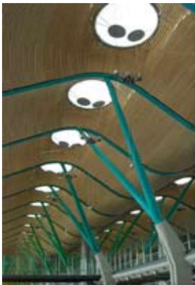
← Richard Rogers & Partners, Terminal 4 Areopuerto de Madrid Barajas, 2004.
