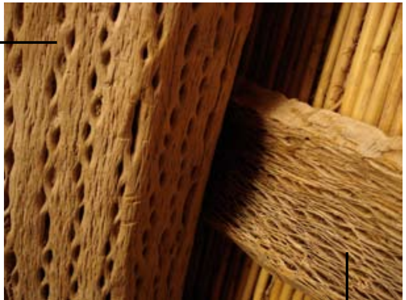
Cubierta realizada en madera de cactus, provincia de Jujuy Argentina, Mayo 2005.
