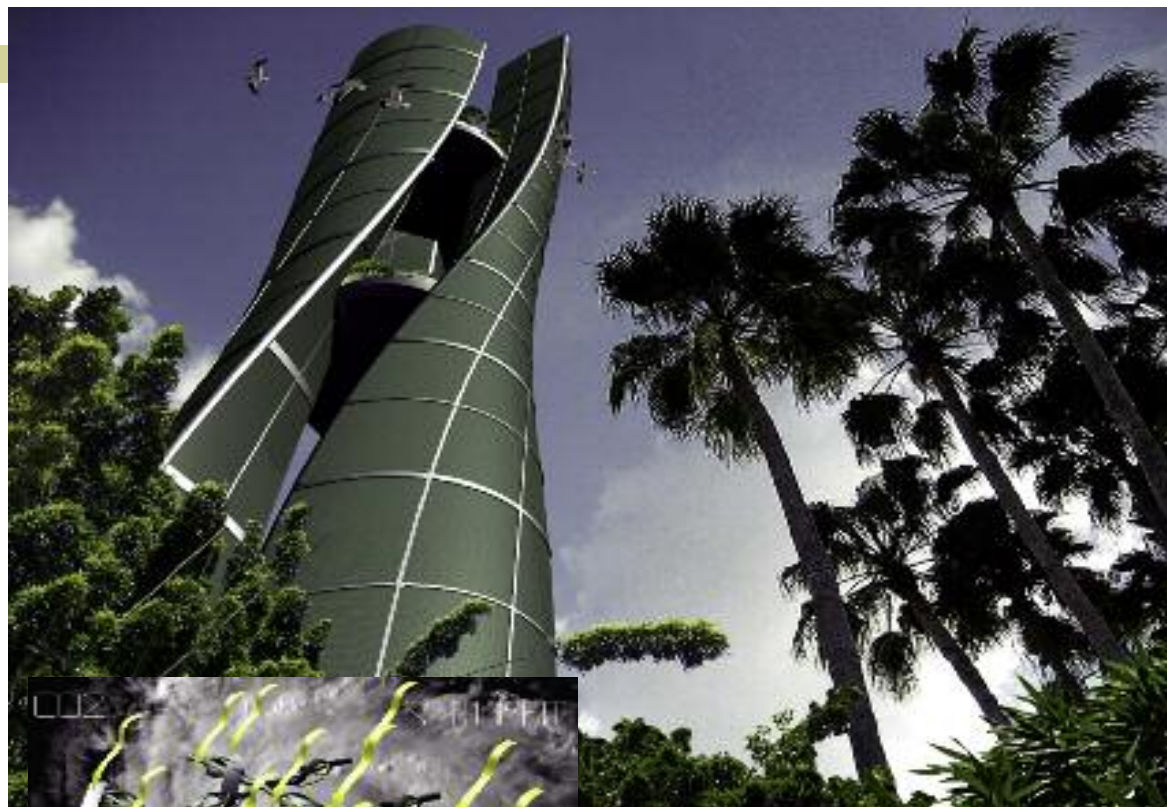
Nano Vent Skin, es un proyecto de “piel viviente” que genera energía solar y eólica y que podría usarse para recubrir edificios. El exterior de la estructura absorbe la luz solar a través de una superficie orgánica fotovoltaica y transmite la energía generada a unas nanofibras insertas en una red de nanocables, y luego a las unidades de almacenamiento al final de cada panel. Cada turbina del panel genera energía por reacciones químicas en sus extremos, donde hace contacto con la estructura. Organismos polarizados son los responsables de este proceso en cada uno de los giros.
